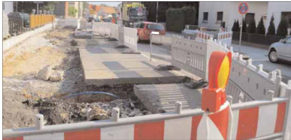
Im 1. Bauabschnitt werden aktuell auf der linken Seite von der "Niederhöchstädter Straße" bis zur "Oberhöchstädter Straße" die Anschlussleitungen an den Kanal hergestellt sowie darauf folgend die Wasserleitungen - Hausanschlüsse hergestellt. Nach der Verlegung der Versorgungsleitungen und des Leerrohres erfolgt in diesem Abschnitt die Versetzung der Bordanlagen und darauf folgend die Pflasterung der Gehwege.
