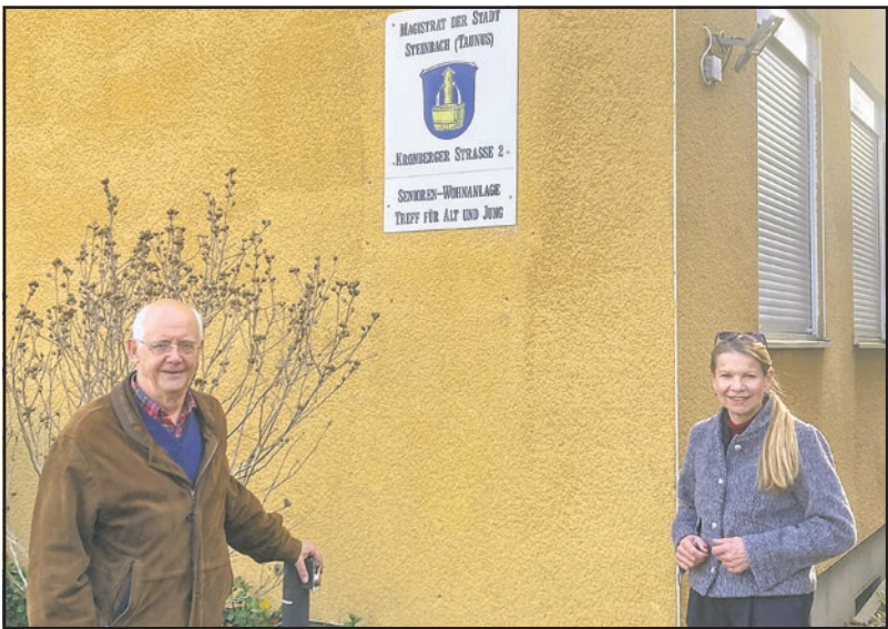
Die CDU-Ausschussmitglieder des Bau-, Verkehr- und Umweltausschuss Yvonne Binard-Kühnel und Heino von Winning informieren sich vor Ort über den baulichen Zustand der städtischen Liegenschaft „Kronberger Straße 2“.
